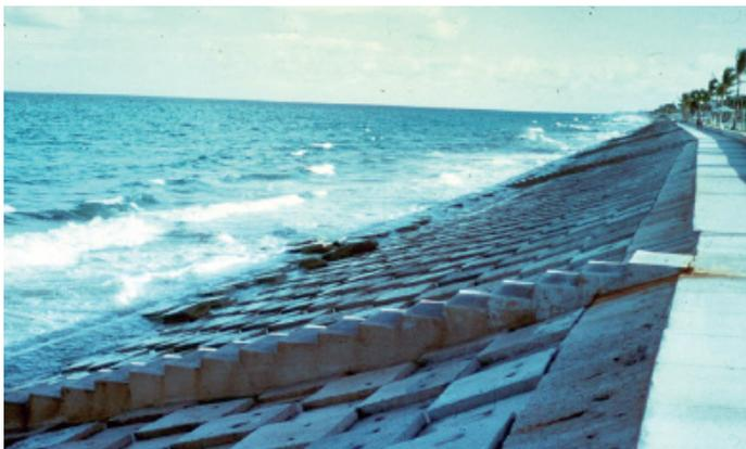
Contoh struktur blok-blok beton
