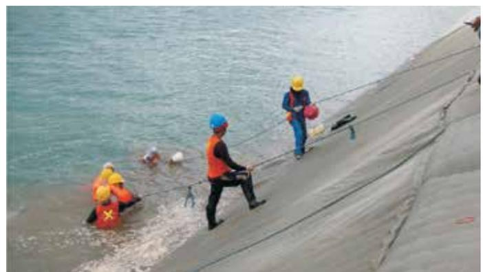
Pemasangan matras beton untuk proteksi erosi
