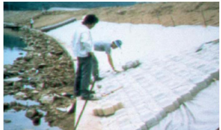
Foto pemasangan blok beton untuk proteksi erosi
