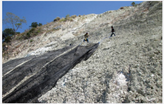
Pekerjaan penggelaran material miragrid® GX
