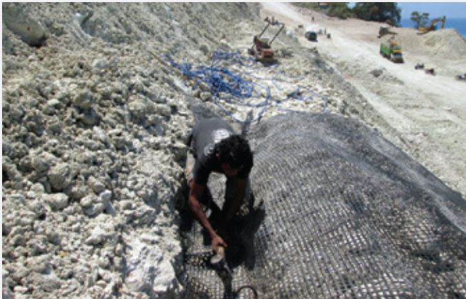
miragrid® GX diangkut di sisi atas lereng
