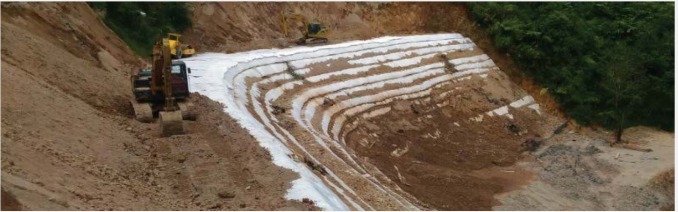
Penyebaran & pemadatan timbunan
