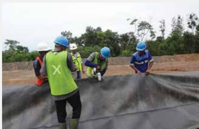
Konstruksi Jalan Setelah Perbaikan
