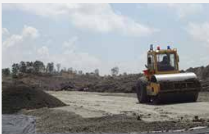
Pemadatan Material Timbunan
